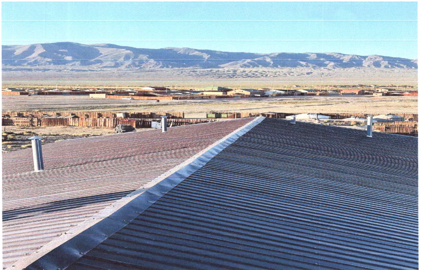
Агааржуулалтын хоолойд малгайвч хийсэн байдал
