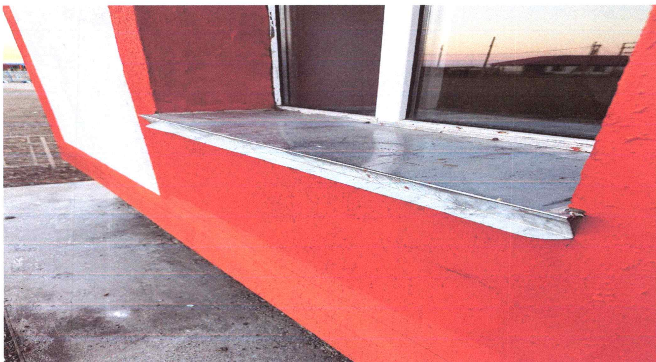
Цонхны усны хаялага төмрийг янзалсан байдал
