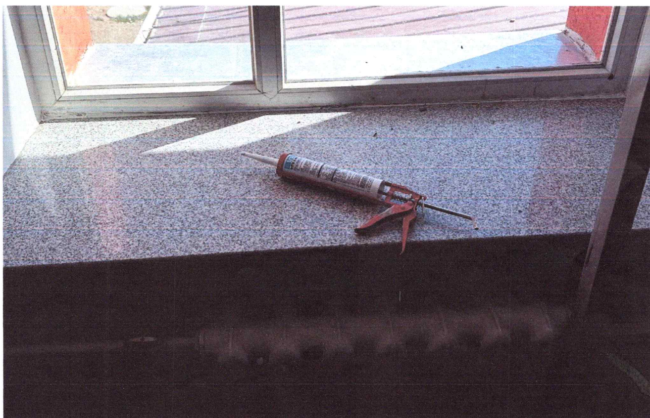
Цонхнуудыг дахин силикондсон байдал
