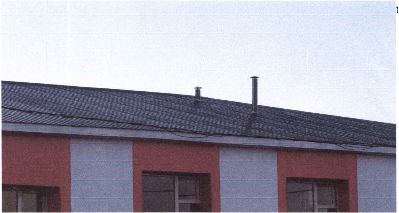
Агааржуулалтын хоолойд малгайвч хийсэн байдал
