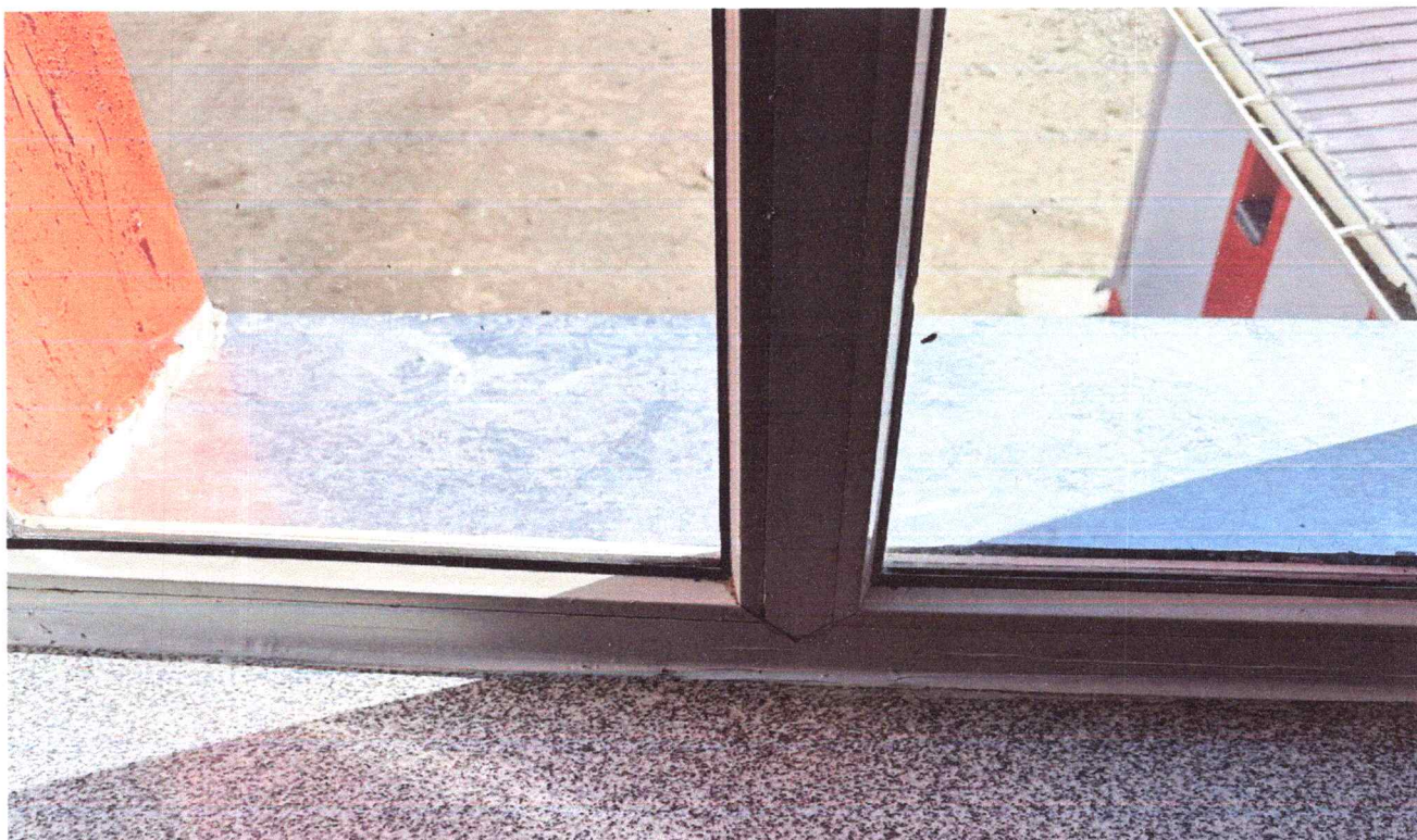
Цонхнуудыг дахин силикондсон байдал
